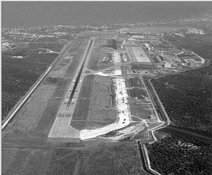
Bari Palese è l'ultimo aeroporto italiano ad essersi dotato di bretella di rullaggio. Nella foto un'immagine dello scalo durante i lavori effettuati nel 2003.
