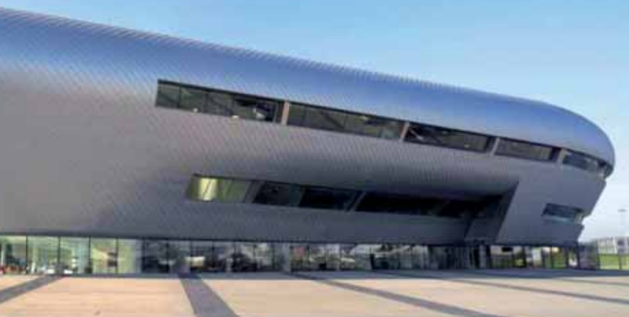
L'aveniristico terminal per l'aviazione generale dell'aeroporto di Farnborough, dove la TAG Aviation ha in corso ingenti investimenti.
