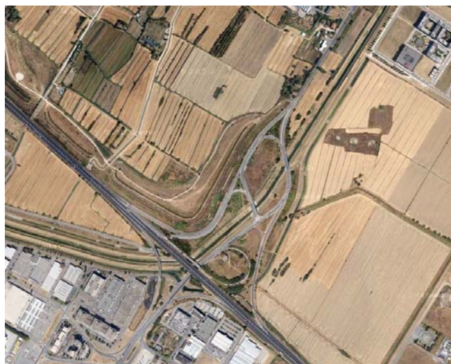
Lo svincolo autostradale di Sesto Fiorentino sulla A11 e il Fosso Reale che dovranno essere modificati per la realizzazione della nuova pista.
